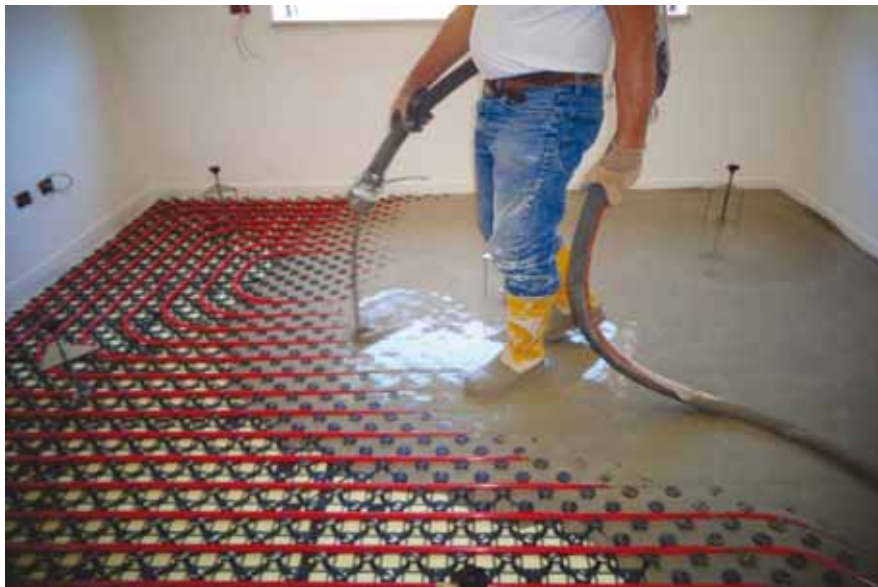
Esempi di impianti a pavimento radiante
